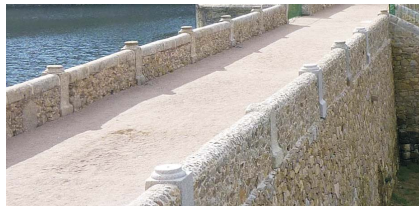
Plintos incorporados en los pretilos del paseadero oeste del dique.
