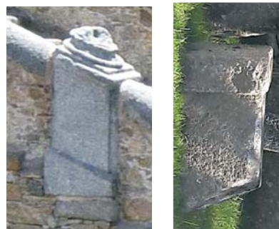
Plinto de la escalera y el monolito presentado en posición vertical, con el extremo inferior incompleto.
